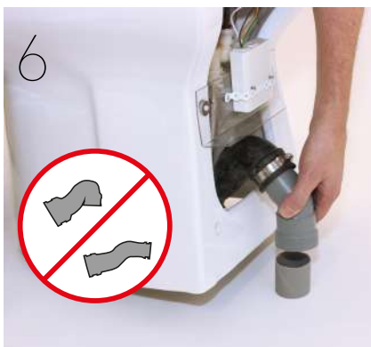
6 Put the WC in place. Use the small plastic plates to balance the WC if the floor is uneven. Ställ WCn på plats. Använd de små plastbrickorna för att balansera WCn om golvet är ojämnt.
