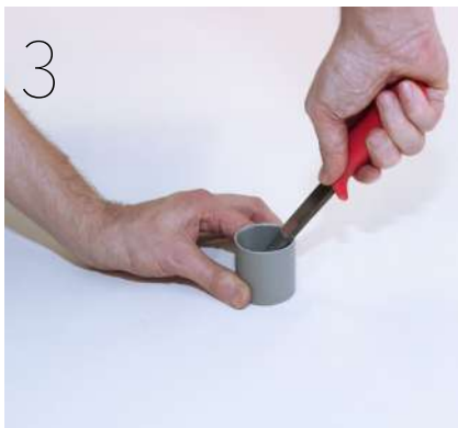
3 Clean the pipe. Rensa röret från ojämnheter.
