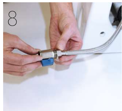
8 The very last step of the installation is connection the water. Test-flush the WC before first usage. Det allra sista steget i installationen är att ansluta vattnet. Test-spolå WCn innan förstaanvändning.
